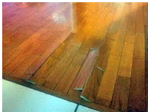
Support pas propre manque d'adhérence de la colle
