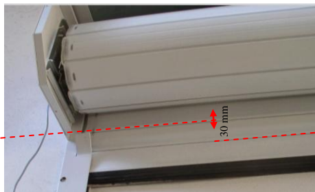
Réglage fin de course en Position Haute
