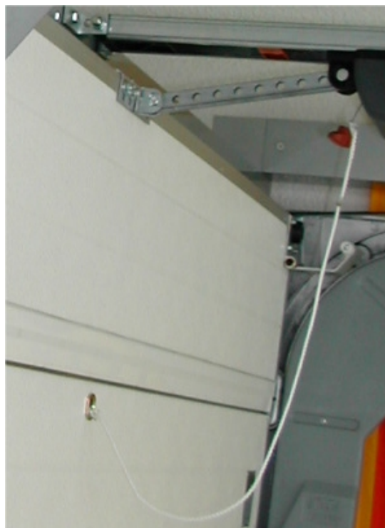
Installation du Kit de déverrouillage
