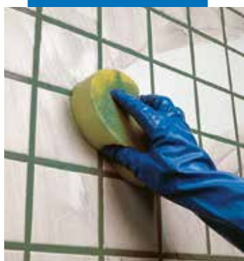
Nettoyage et finition des joints à l'éponge, en mur
