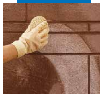
Nettoyage et finition des joints à l'éponge
