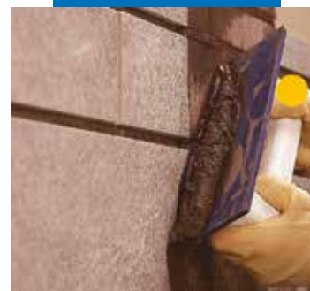
Autre exemple d'application d' Ultracolor Plus à la spatule en caoutchouc en mur
