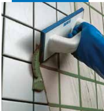
Jointoiment en mur avec la spatule caoutchouc
