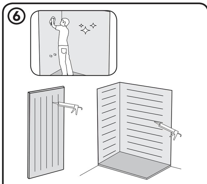
Avant de procéder au collage, bien vérifier que la surface est parfaitement nettoyée, sèche, lisse et dégraissée.
