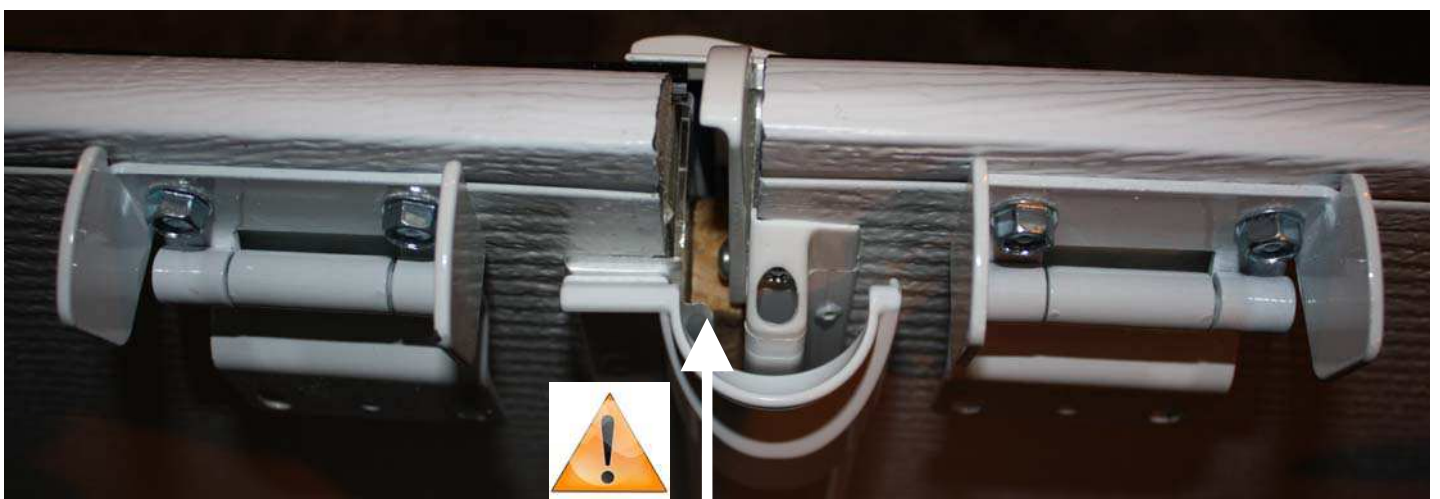
3 – Positionner une cale de 12 mm entre le dormant et l’ouvrant
