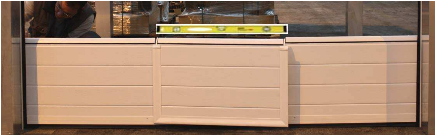
1 - Mise en place du panneau BAS Le panneau BAS doit être impérativement de niveau
