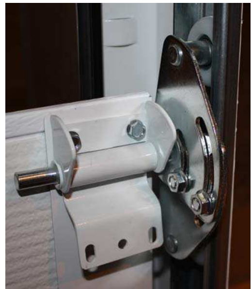
2 – Montage des Charnières d’extrémités avec les vis auto-taraudeuses
