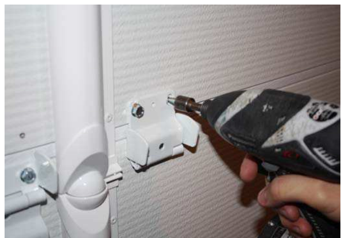
5 – Fixation des charnières intermédiaires avec les vis auto-taraudeuses
