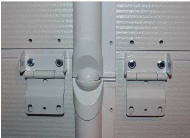
5 – Fixation des charnières intermédiaires avec les vis auto-taraudeuses
