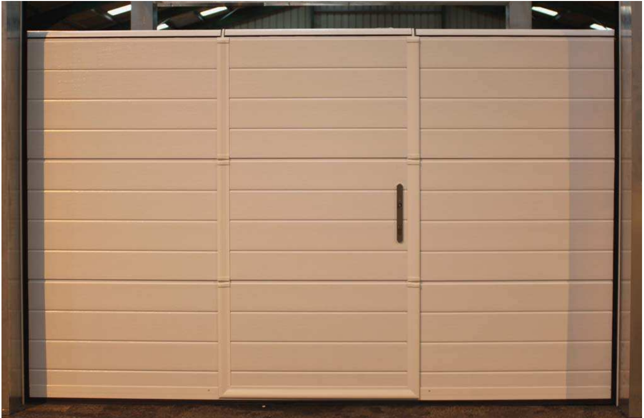
9 – Montage du 3 ième panneau terminé
