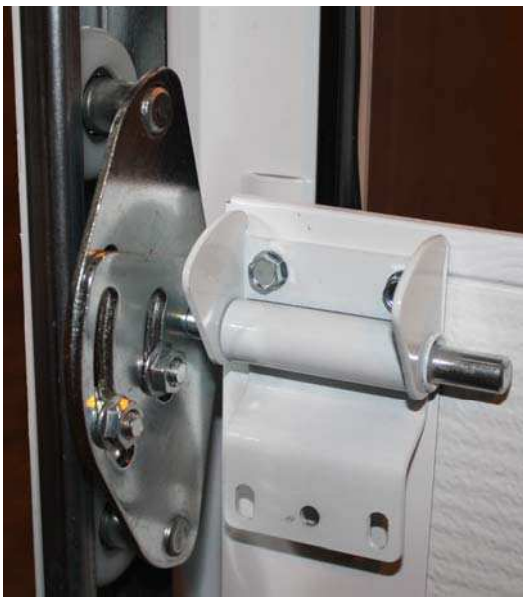
2 – Montage des Charnières d’extrémités avec les vis auto-taraudeuses
