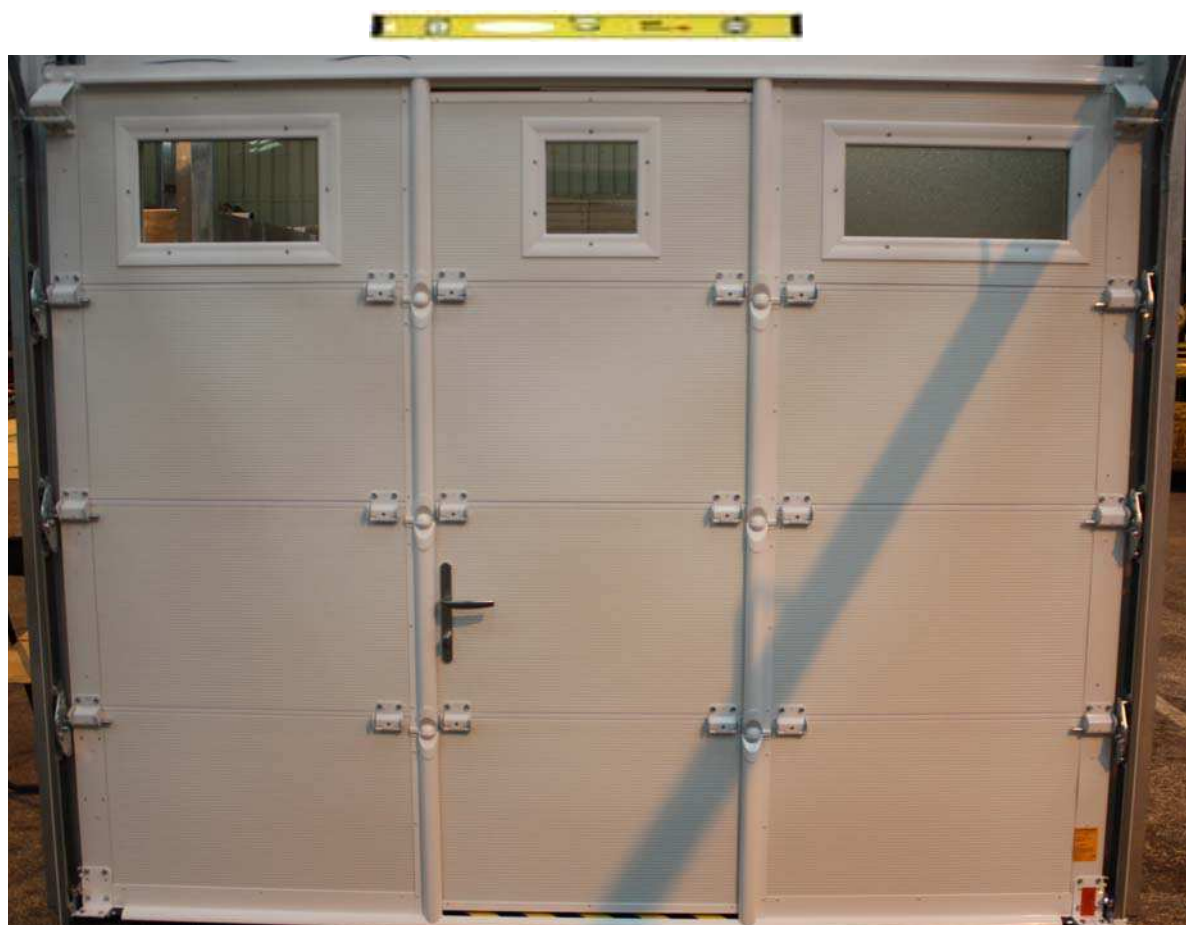
Vue de l'intérieur – Montage du tablier terminé
