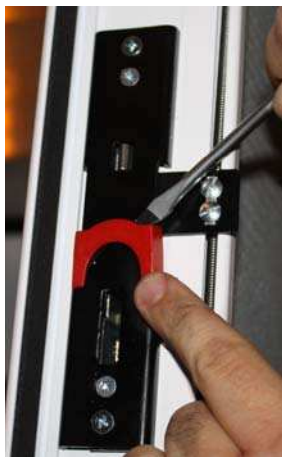
14 – Après passage du ressort et serrage des 2 vis sur chacun des coffres, retirer les clips rouges
